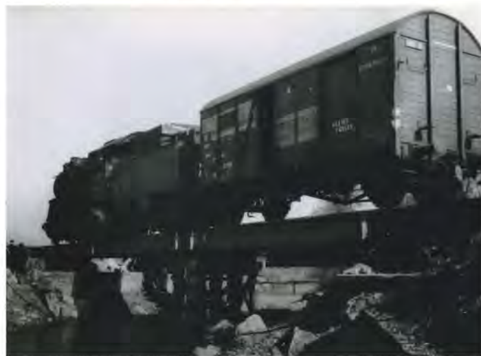
Jernbanedrift i Tyskland, april 1947: Ved Meckelfeld syd for Hamburg går banelinjen endnu over en interimistisk nødbro. Både lokomotiv og vogn er til rådighed for besættelsesstyrkerne. Arkiv Gerd Neumann.
