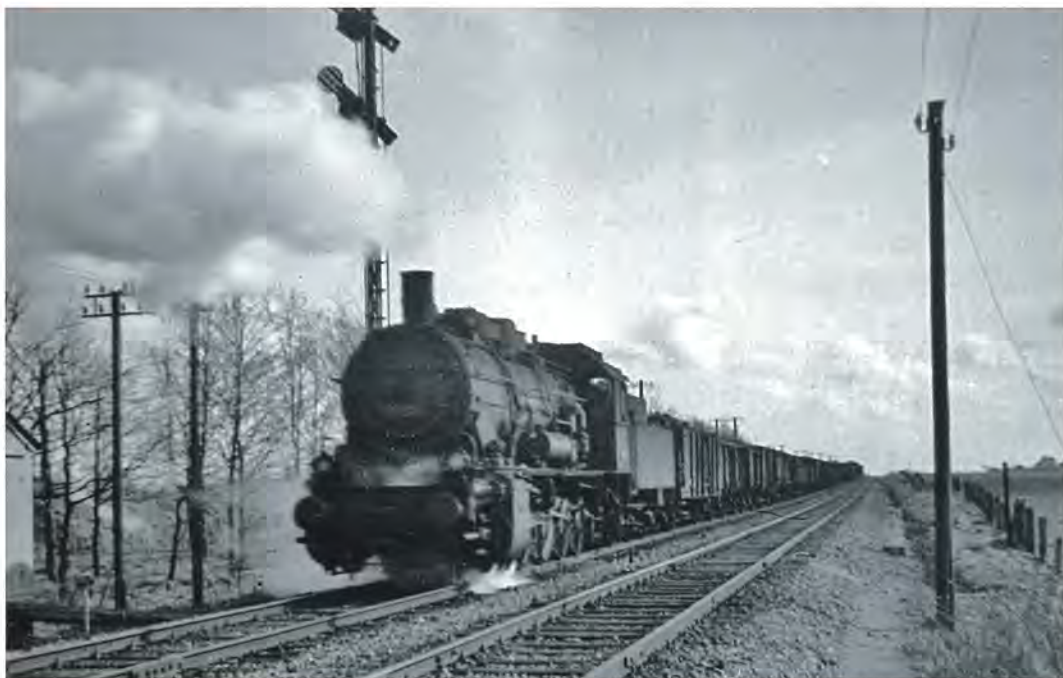
Et stort godstog fremført af en BR 57, en tysk godstogs-lokomotivtype, passerer i foråret 1946 indkørselssignalet til Padborg station fra syd. Signalet, der stod omtrent i grænselinjen, viser ikke "gennemkørsel" men tysk signalbillede; "indkørsel til afvigende spor". Fotografiet er som flere af andre af denne artikels fotos desværre lidt uskarpt, hvilket læserne dog må leve med, da billedet ikke så let lader sig tage om i dag. Foto W.E. Dancker-Jensen, arkiv Banebøger.
