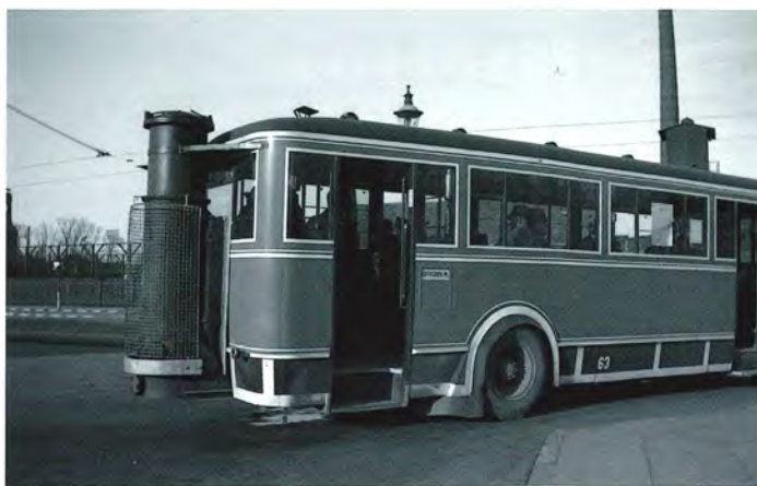
Gengasgeneratoren fyldte ret meget bag på busserne, og opfyrringen var livsfarlig pga. kulilte. Bussen forlader endestationen ved Tuborg på Strandvejen. Foto Jan Walter 1941.
