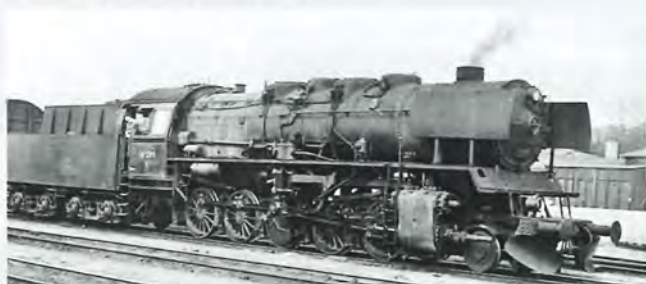
Litra N 209 med skivehjul på forløberen, fotograferet i 1965. Førerhustaget er helt glat. Foto A. Kirkeby, arkiv www.Jernbanen.dk .
