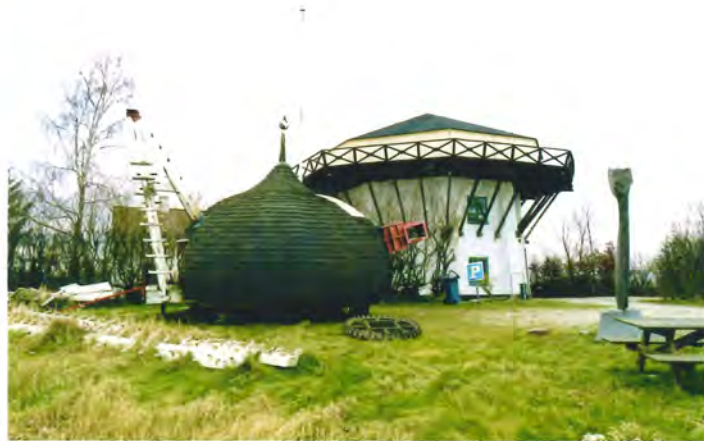
Går man i stå undervejs i ombygningen, er det ikke så slemt - for sådan så Egebjerg Mølle på Sydfyn ud i vinteren 2002 med møllehatten på jorden og ingenting over løbebroen. Foto Flemming Søeborg.
