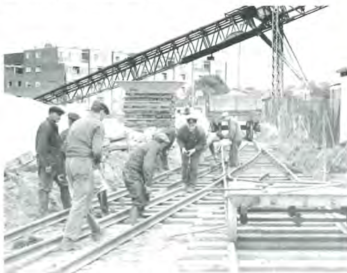
Udskiftning af spor på Nakskov Havn i 1960'erne. Enten lægges der treskinnet spor, eller også fjernes smalsporet. Arkiv Erik Petersen.
