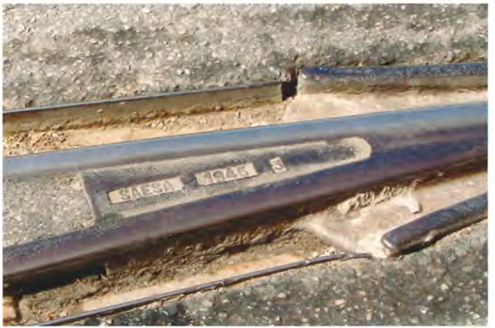
Der er otte sporskifter på strækningen, og flere af dem er ret gamle som dette hjertestykke fra 1945. Foto spor og baner.
