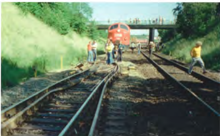
Også et sporskifte blev ødelagt ved afsporingen ved Rungsted i foråret 1976. Foto Vagn Holstein.
