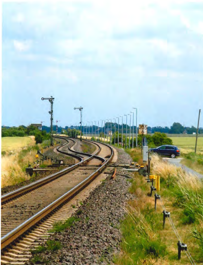
Krydsningssporet ved Lehnshallig med de flotte armsignaler, den 6. juli 2014.
