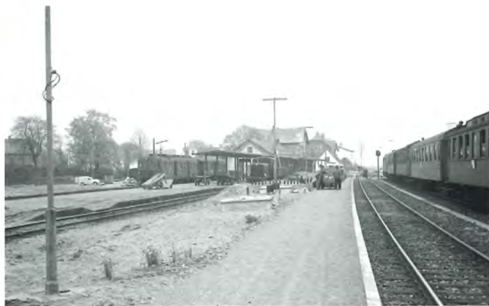
Læssevejen samt perron og stationsbygning i Vojens den 22. maj 1962. Foto HBDS.
