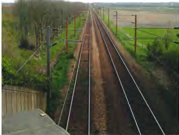
Hovedvej A 8 føres over banen ved Vejebak-Fårhus. I baggrunden kan man ane overgangen til enkeltsporet sydpå. 12. april 2014. Foto Spor og baner.
