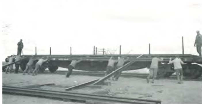
Fra hverdagens hårde slid – skinner læsses med håndkraft på DB-fladvogn. Kværkeby, april 1957. Foto HBDS.
