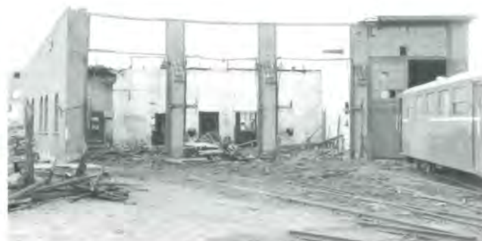
De sørgelige rester af den brændte del af remisen, hvor de tre Triangelvogne stod. På grund af muren i skinnebussens del af remisen slap den med mindre skader.
