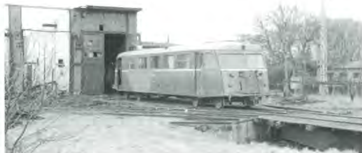
Da vi kom til Køge, kørte vi straks ud til remisen, hvor SM 5 allerede holdt. Man ser tydeligt "brandsåret" ved de to sidste vinduer. Signalet til højre tilhører DSB.
