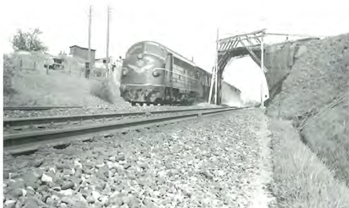
Ukendt My passerer den gamle Midtbanebro ved Kværkeby under nedrivning maj 1957. Foto Holger B.D. Sørensen, He- dehusene.
