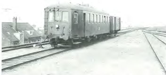
M 20 ruller endnu en gang ind på Hirtshals station, denne gang med D 63 på slæb. Vognen var bygget af Scandia 1927 og var en person-, post- og rejsegodsvogn.
