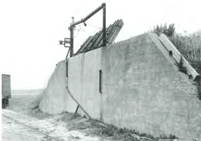
AHJ, Lundergaarde trb. 1. april 1969. Her er "læssevejen" eller i nogle tilfælde tipvognsbaner hævet så meget, at man herfra kan "styrte" sten og grus ned i de opstillede vogne.
