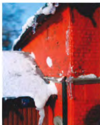
Et knækket nedløbsrør er vist ikke så godt – det giver anledning til flere istapper.
