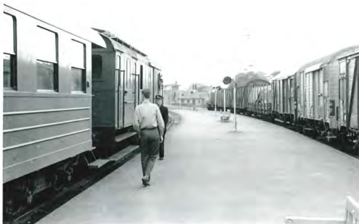
Godstoget til Hirtshals med HP 30 foran skulle til at afgå, så jeg nåede kun at tage et billede bagfra. Til venstre er HP 11 spændt for toget til Åbybro. Man ser tydeligt, at bogievognen har forstærkninger på siden.
