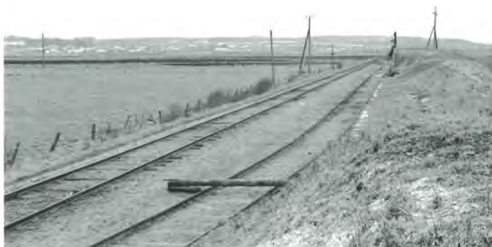
AHJ, Lundergaarde trb. 1. april 1969. Her er "læssevejen" eller i nogle tilfælde tipvognsbaner hævet så meget, at man herfra kan "styrte" sten og grus ned i de opstillede vogne.
