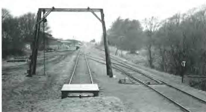
AHJ.Solbjerg. Terrain m. galgekran, set mod NV. 30. 3 1969.
