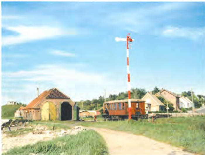
Motorvognen måtte helt ud til indkørselssignalet, hvor drejeskiven lå, for at blive vendt. Herude lå også en tosporet remise.
