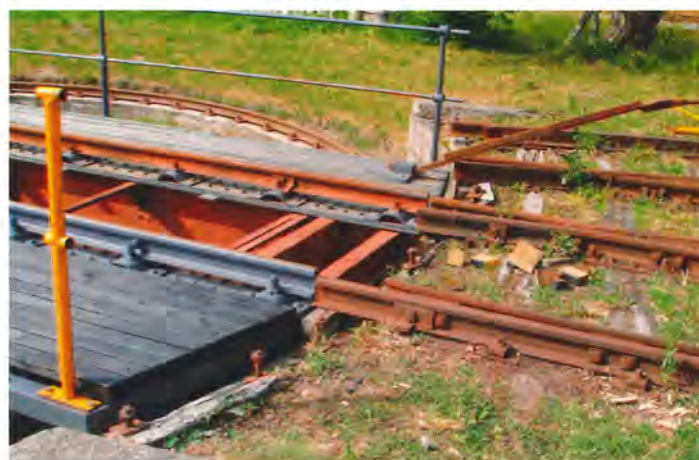
Drejeskivens spor ligger markant højere end de tilstødende spor gør.
