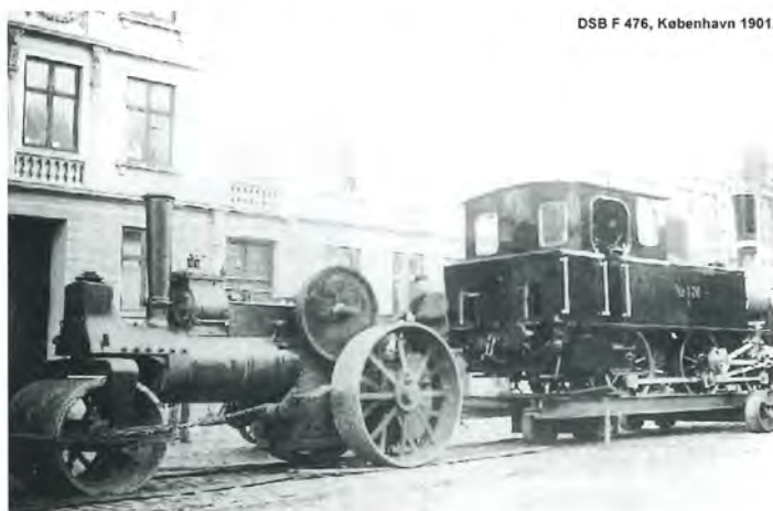
En af maskinerne, F 476, der blev bygget i 1901 af Smith, Mygind og Hüttemeier på Nørrebro i København. På grund af manglende sporforbindelse måtte det transporteres på en blokvogn af et lokomobil (damptrømler) til nærmeste læssevej. Arkiv www.jernbanen.dk .
