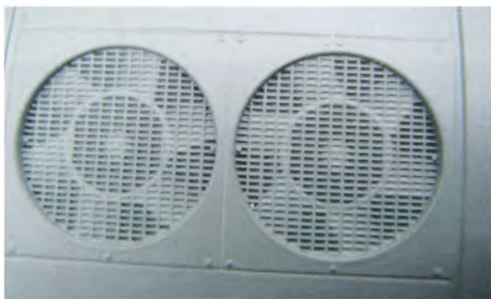
Fint detaljerede ventilatorer på taget.
