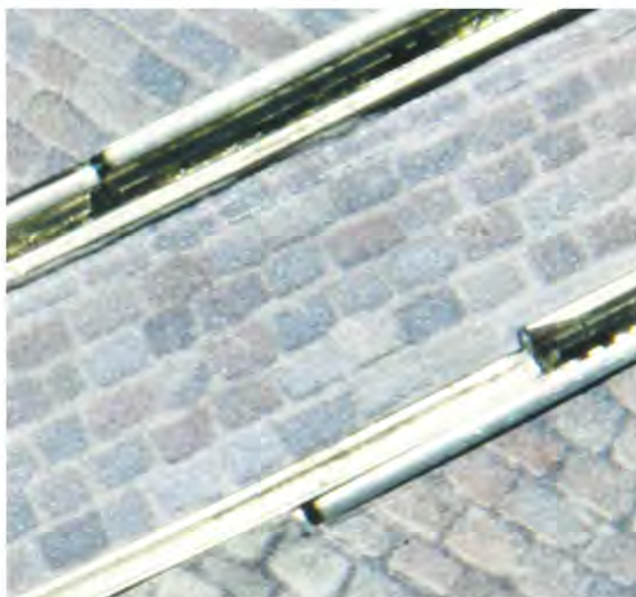
Overgangen mellem de almindelige havneskiner og specialskinnen.
