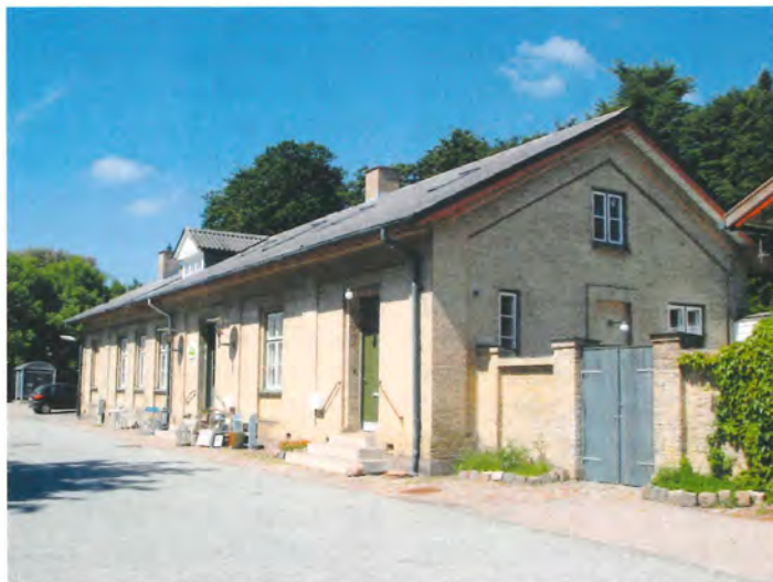
Som det ses, er selv muren mellem de to bygninger bevaret.
