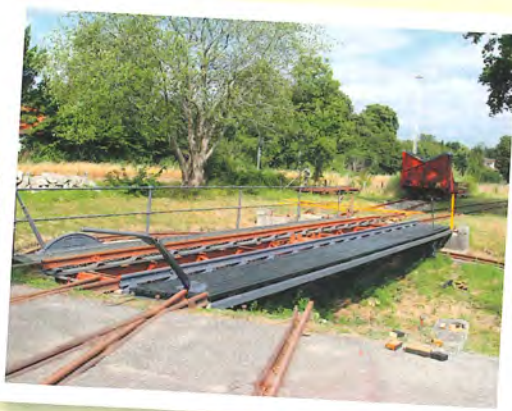
Nyrenoveret drejeskive og en gammel sneplov ved Jernbanemuseet i Ryomgård.
