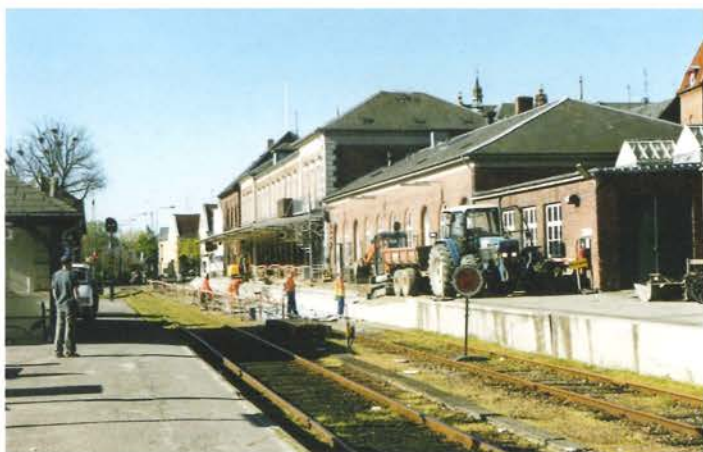
Højtalerne kunne også hænges op på murene – lige ved hjørnet på sidebygningen. Svendborg 2001, Foto F. Søeborg.
