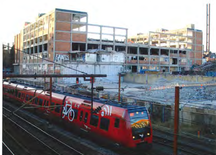
Station HOF under nedrivning, marts 2013. De to spor førte ind gennem de to hvide, tilmurede åbninger nederst t.v. på bygningen. Foto Flemming Søeborg.
