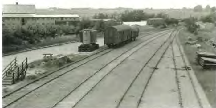
Jeg gik op på gangbroen og tog et billede i nordlig retning. Midt i billedet holder to godsvogne, som sikkert er dagens godstog fra Silkeborg. Nærmest holder en stor tysk vogn, som skal til maskinfabrikken i baggrunden til venstre, og foran den står en DSB PT, som er læsset med kunstgødning fra Kalundborg. På fabrikkens sidespor kan man skimte tre store, tyske vogne. På læssevejen står en transformator på en masse sveller, hvilket tyder på, at den er kommet med banen. Til venstre i billedet står en fin mobil læsserampe og foran den ses en stationær læsserampe, der er vinkelret på sporet.
