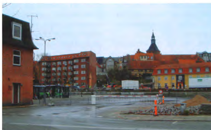
Bomme og gitre spærre for uvedkommende færdsel ved rutebilstationen, Svendborg november 2012. Foto Spor og baner.
