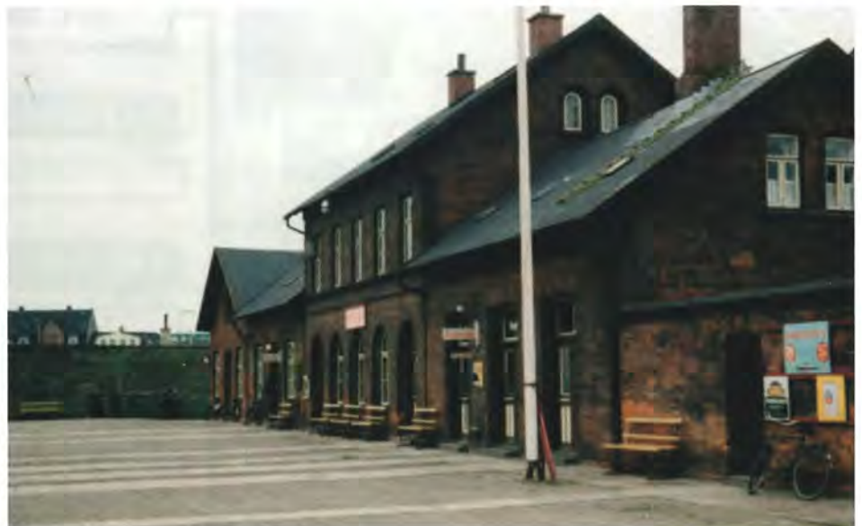
Stationsbygningen på Nørresundby Havn.
