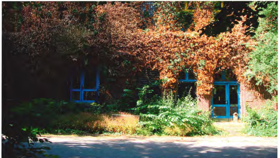
Der var engang en station...Brøns set fra gadesiden - snart er bygningen helt forsvundet.
