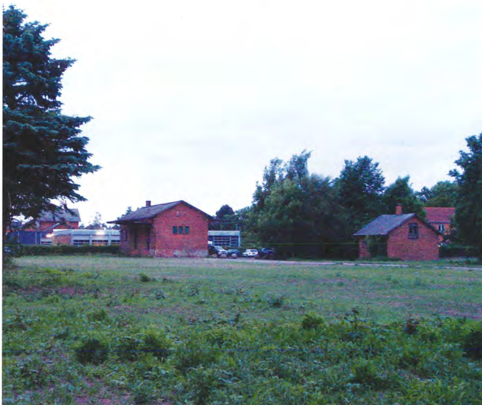
Det tidligere banegårdsareal er sikkert en udmærket boldplads, men ingen benytter grunden. Imens forfalder pakuset og rangerhestestalden mere og mere. Hvad f... er meningen?
