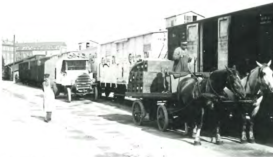
ZA 99 559 på Frederiksberg station, sommeren 1927. Uden skydedøre, men endnu med to vandrette ventilationsgitre på vognsiderne. (Danmarks Jernbanemuseum via www.jernbanen.dk )
