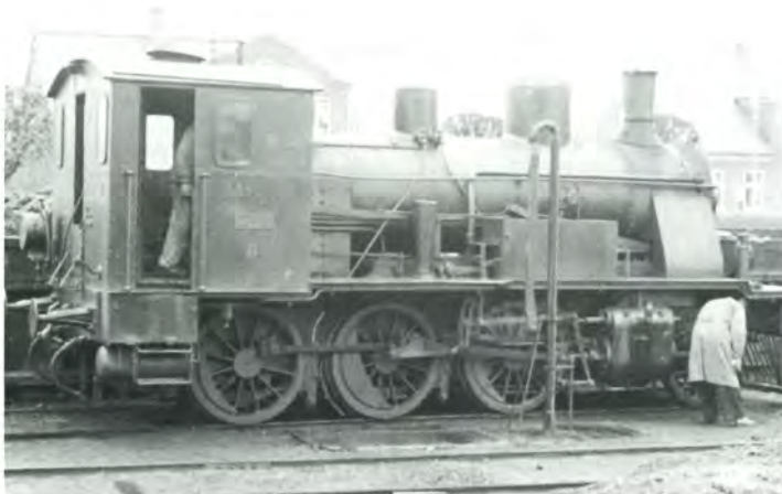
Efter at have stødrangeret togførervognen ind på et sidespor kørte nr. 6 hen til dampremisen for at få nye forsyninger af kul og vand. Lokomotivføreren er ved at inspicere lokomotivet. Bemærk den noget simple vandkran. Som det ses, så er der dør og overgangsbro på bagsiden af førerhuset. Tidligere var der også rækværk hen ad siden og overgangsbro foran, men det er fjernet. For at spare penge var det meningen, at fyrbøderen skulle kunne gå ind i toget og billettere under kørslen.
