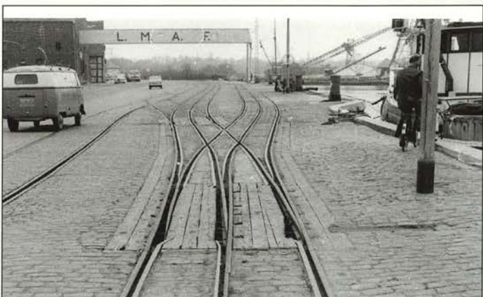
De trestrengede spor på havnen virkede temmelig indviklede, og man kunne let blive i tvivl om hvilket spor, der var beregnet til roebanen. Imidlertid er normalsporvidden 1435 mm og roebanesporvidden 700 mm, så det må være smalsporet til venstre, som er til roetogene.
